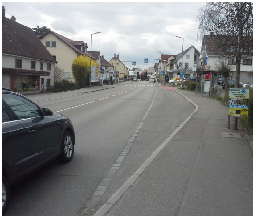
Enger, für den Radverkehr freigegebener Fußweg im Verlauf der Ehinger Straße Mitte (B 311); besondere Konfliktstellen im Haltestellenbereich
