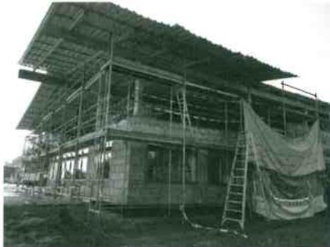
Turm und Vereinsheim jetzt wie ein Rohbau aus. Nach Vorlage der Wiederaufbaupläne vor dem Techn. Ausschuss der Stadt Erbach wurde das Brandschutzkonzept überprüft. Dies führte zu einigen Verbesserungen, u. a. Brandmauer, 2. Fluchtweg vom Obergeschoss, Löschwasserbevorratung.
