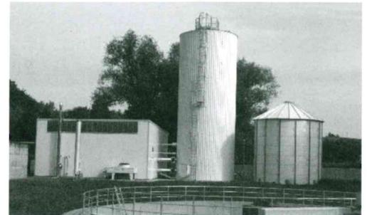
Beispiel für eine Hochlastfaulungs-Anlage (Quelle: Fraunhofer IGB)
