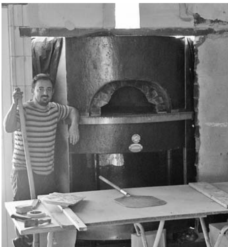
Maurizio Adamo beim Einbau des neuen Pizzeriaofens
