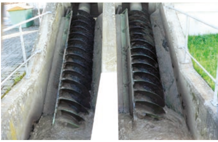
[12] Rücklaufschlamm pumpwerk
