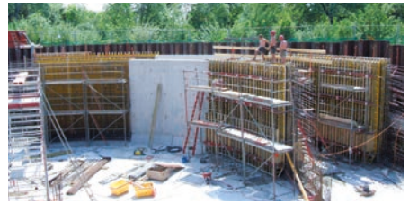
Betonieren der Wände
