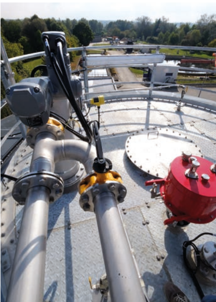
(15) Kopf der Hochlastfaulung mit Aufsatz zur Gasentnahme
