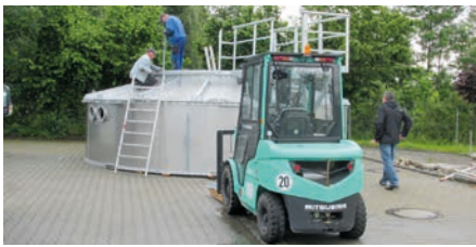
Montage der Hochlastfaulung
