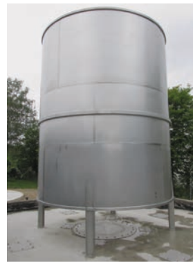
Das Strömungsleitrohr der Hochlastfaulung ohne Edelstahlfaulbehälter
