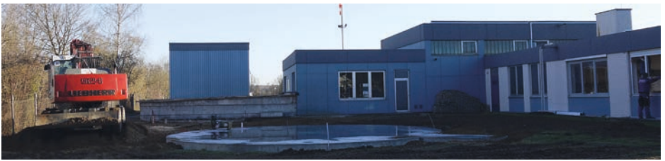
Die Fundamente des Faulturms und des Gasspeichers
