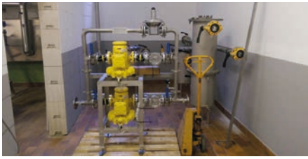
Montage der Gasreinigung
