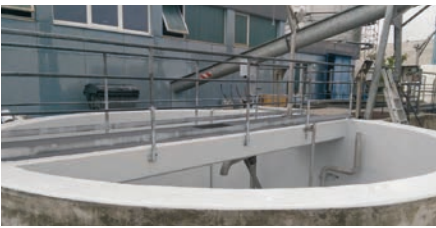
Betonsanierung des Voreindickers
