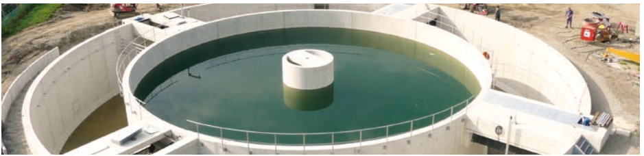
Erweiterung der Kläranlage 2009
