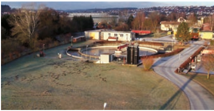
Kläranlage vor der Erweiterung
