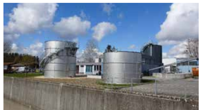
Abbildung 25: links Schlammstapelbehälter
