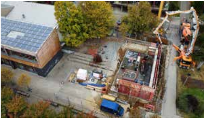
Abbildung 6: Neubau der Heizzentrale
