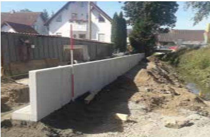
Abbildung 26: Hochwasserschutzmaßnahme am Erlenbach, Bauabschnitt 4 im Bau
