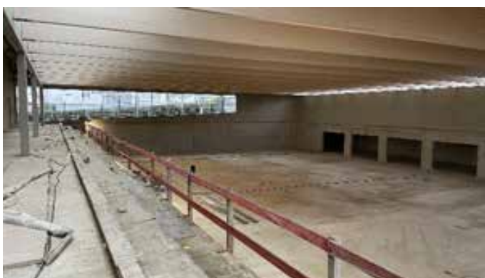
Abbildung 5: Blick in den Rohbau der Sporthalle in Richtung Westen
