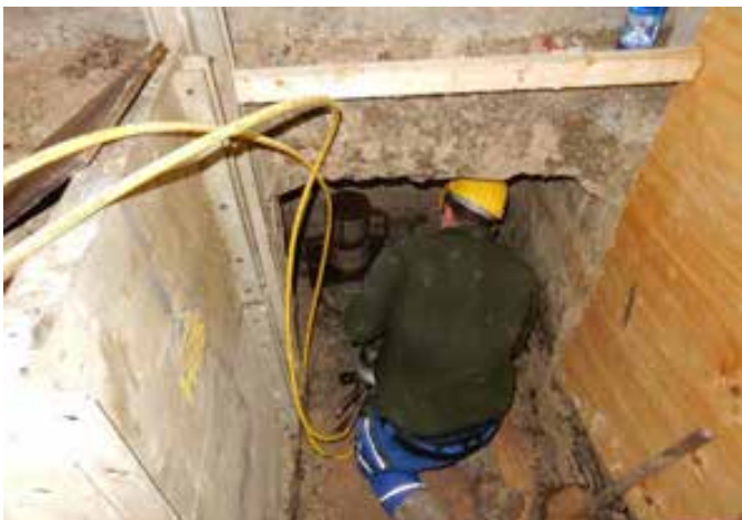
Abbildung 13: Arbeiter beim Pressen eines Pfahls
