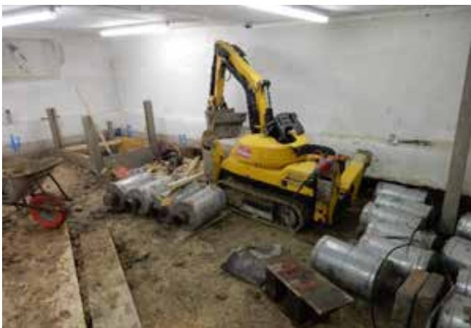
Abbildung 12: Bagger und Presspfahlsegmente im Keller des Rathauses
