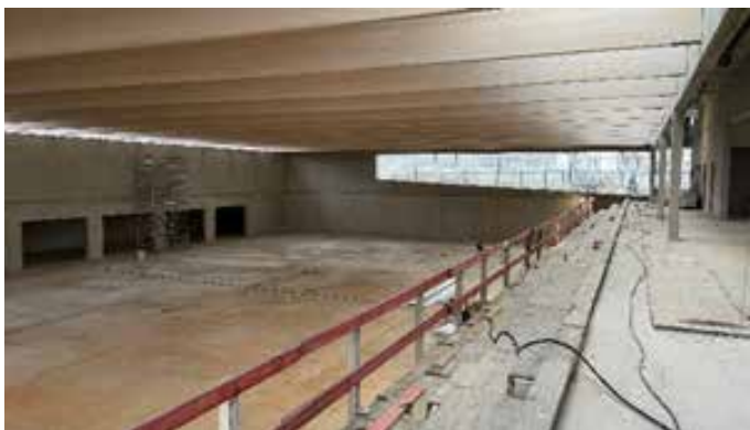
Abbildung 4: Blick in den Rohbau der Sporthalle in Richtung Osten
