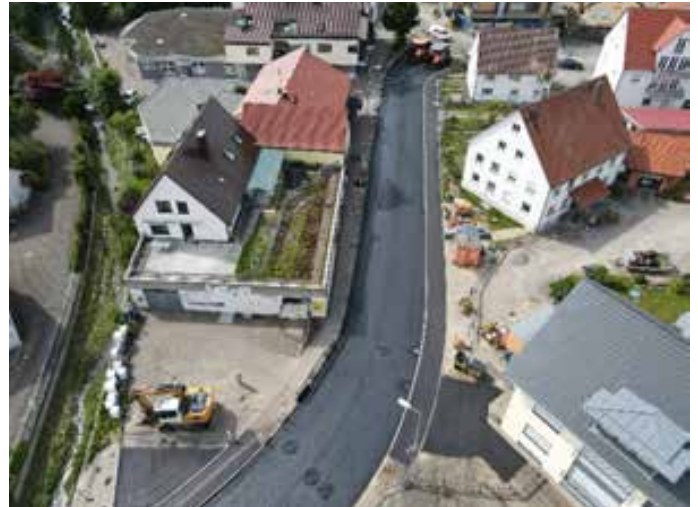
Abbildung 10: Sanierung Donaustetter-Str. und südl. Erlenbachstraße
