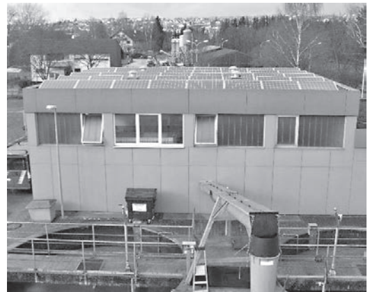
Ein bestehendes Klimaschutzprojekt in Erbach: Die Photovoltaikanlage auf dem Dach der städtischen Kläranlage. Die gewonnene Energie wird zu 100% in der Kläranlage genutzt.
